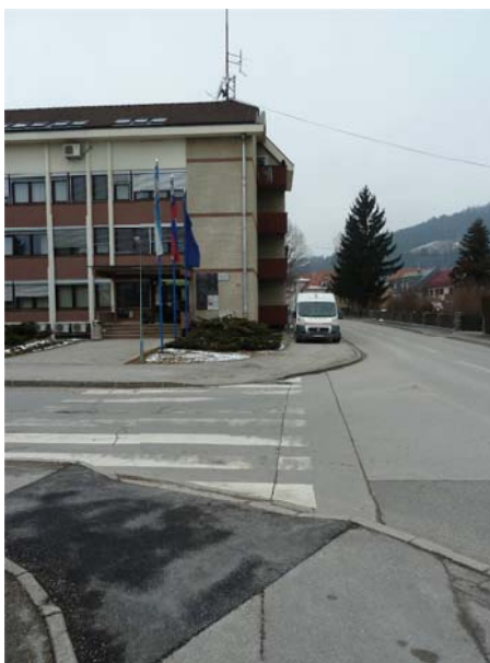
Slika 4: Popravljen prehod pred Upravno enoto Slovenj Gradec
